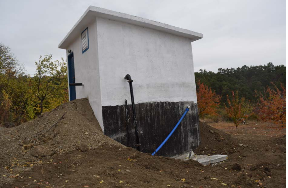
Pazarlar-Sarayköy-Biriktirme ve Terfili tesis deposu yapımı
