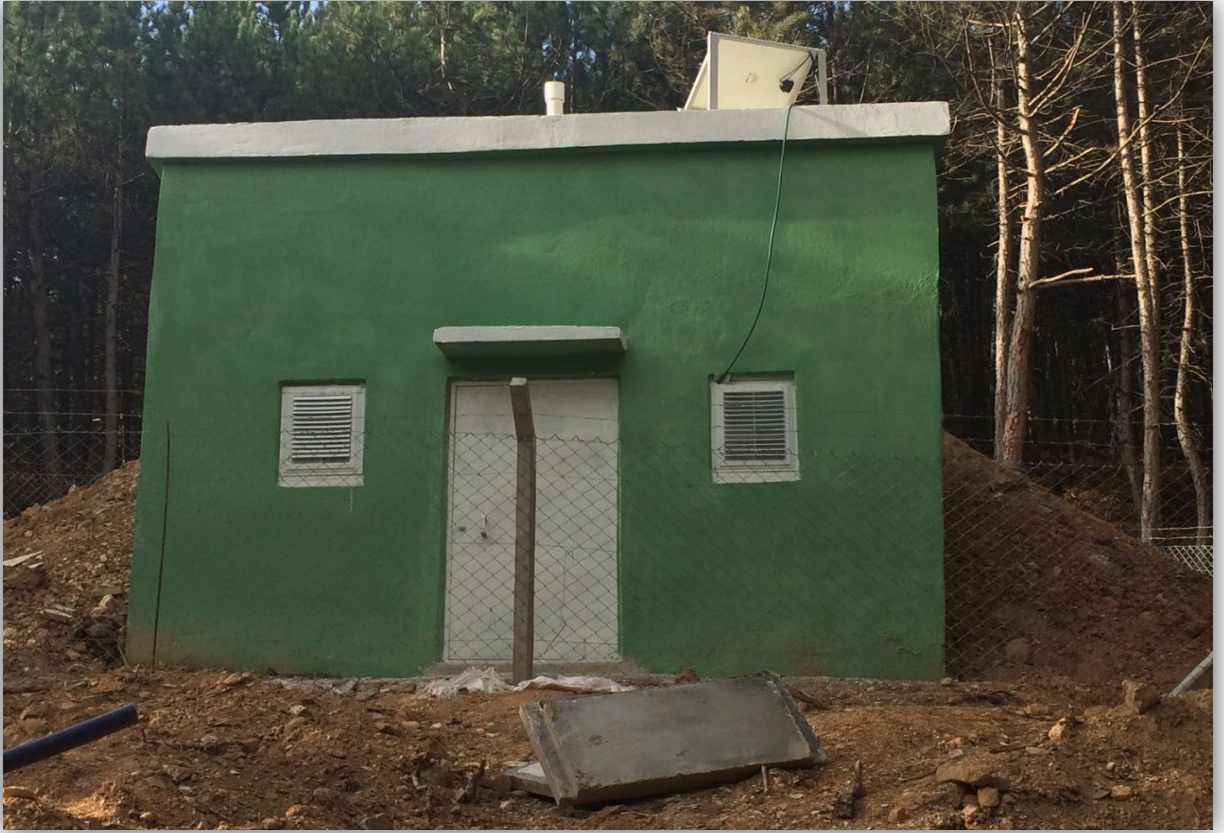
Dumlupınar-Ağaçköy 50 m3lük depo yapımı
