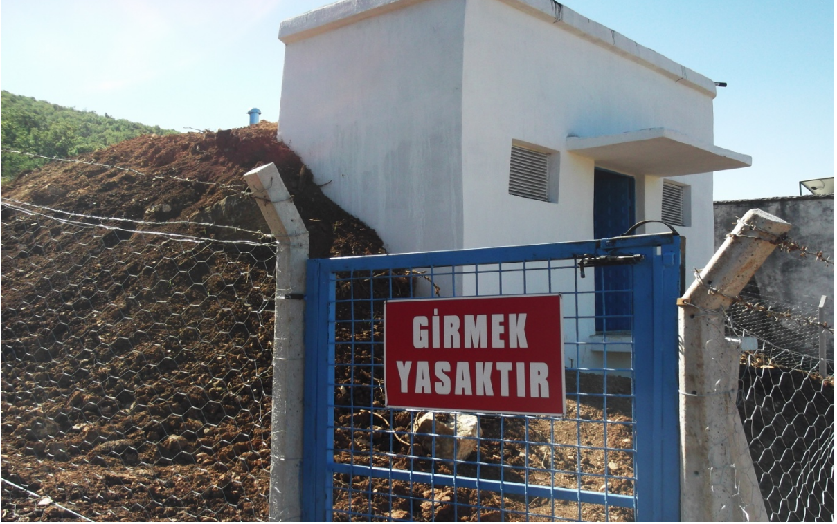
Domaniç-Durabey- 50 m3lük depo yapımı
