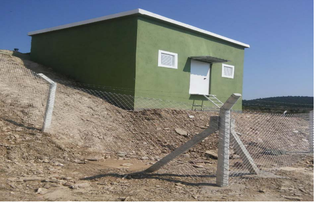
Altıntaş-Beşkarış köyü 100 m 3 lük içmesuyu deposu yapımı
