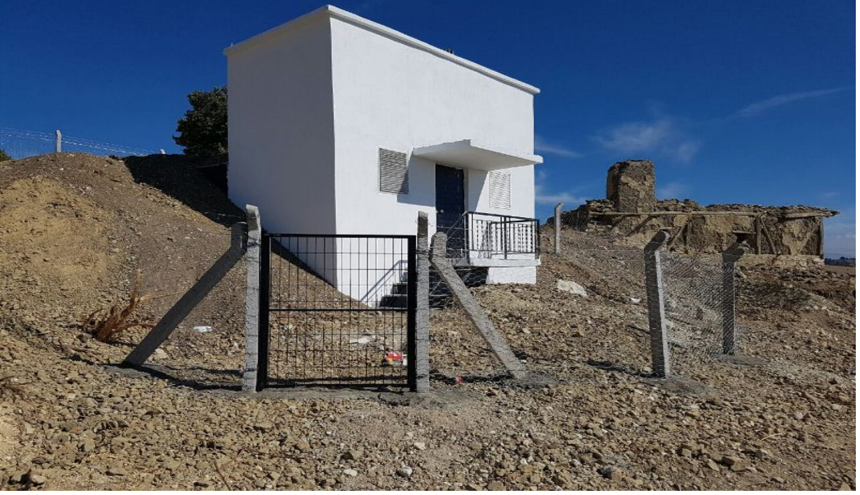
Gediz-Çeltikçi-50 m 3 lük depo yapımı
