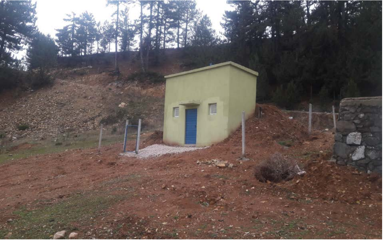
Hisarcık-Kızılçukur 50 m 3 lük depo yapımı
