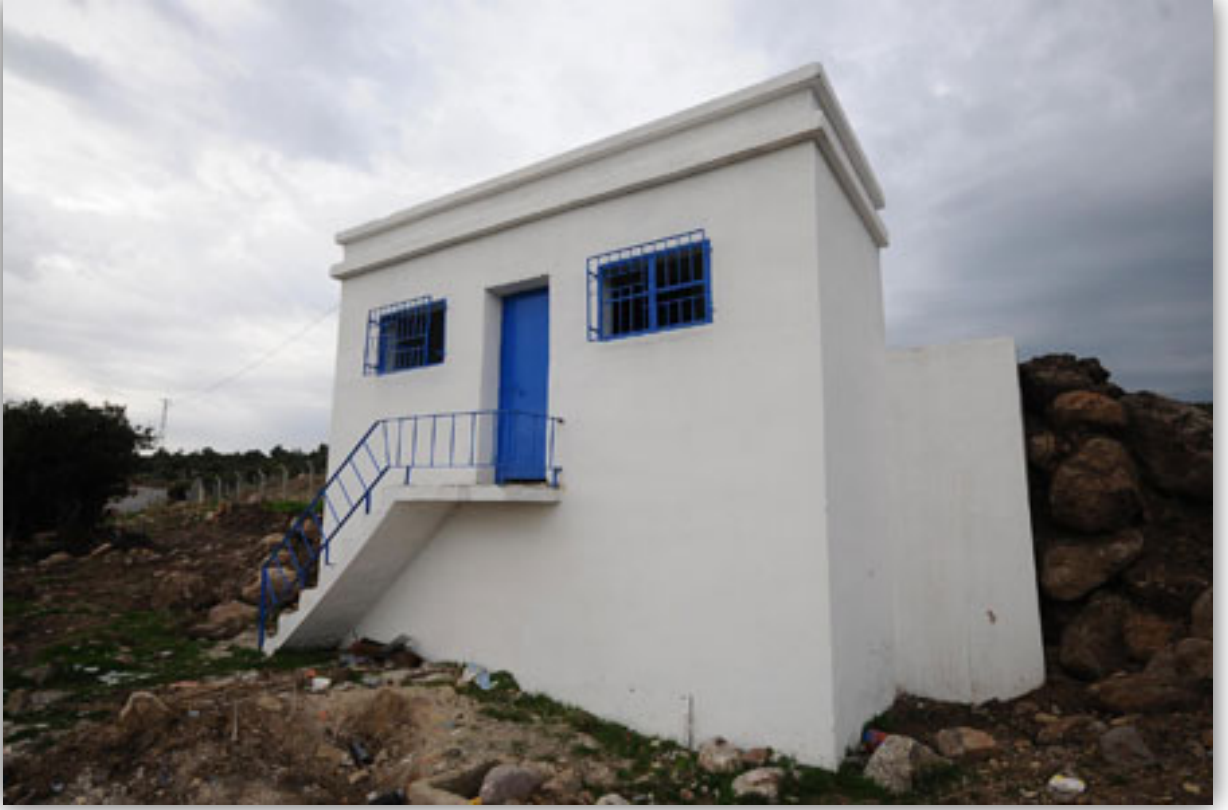
Emet -Aydıncık köyü 1000 m3 lük içmesuyu deposu yapım işi
