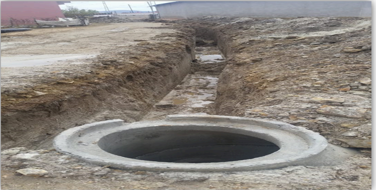
Emet-Yenice köyü foseptik bağlantı hattı tamamlama
