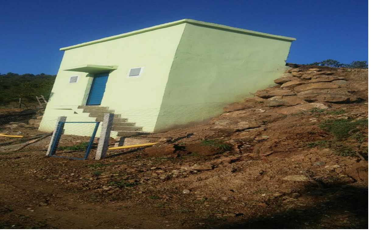
Hisarcık-Karaağıl köyü 50 m 3 lük depo yapımı
