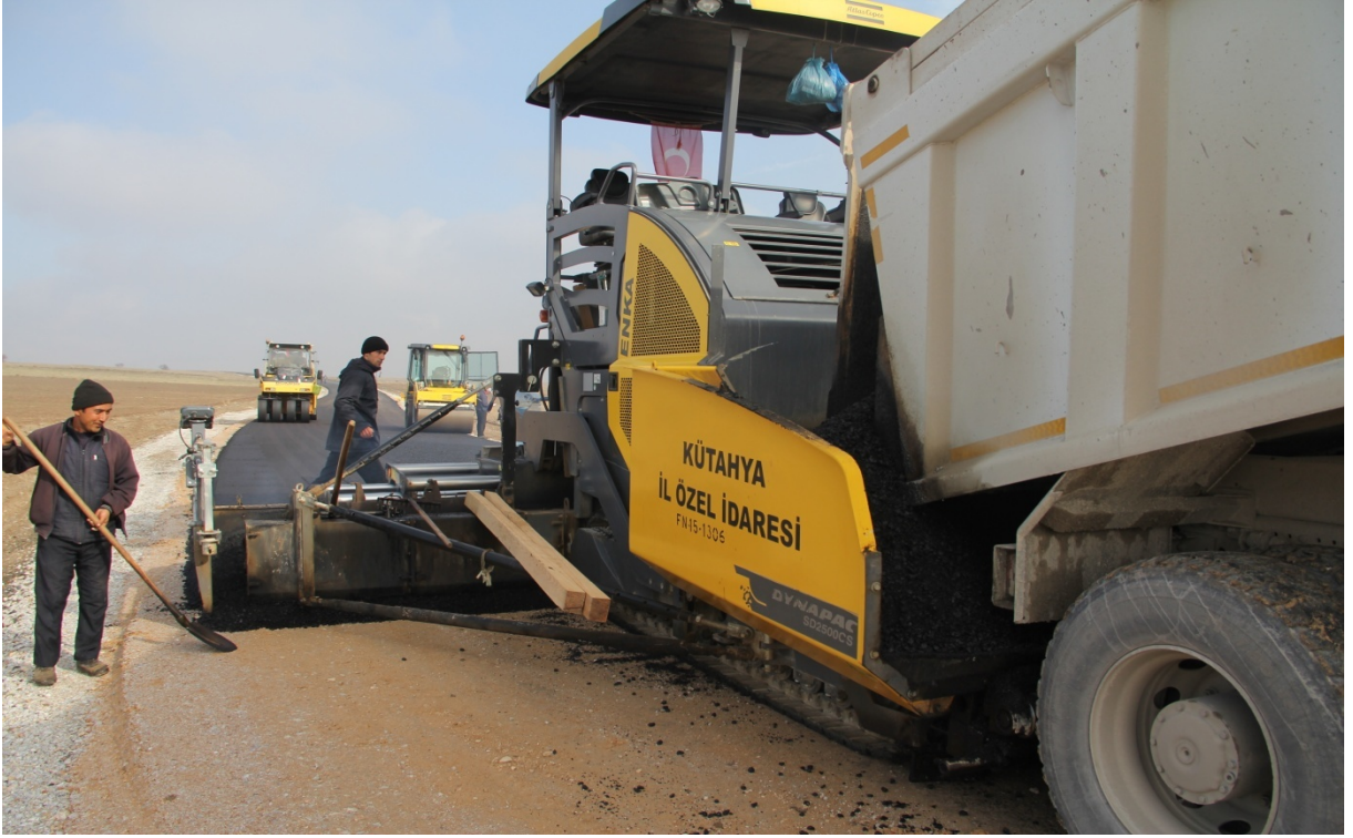
Merkez- Turgutlar yolu (BSK) Sıcak asfalt çalışması
