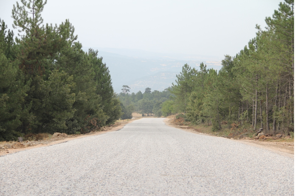
Tavşanlı-Burhan köy yolu 6 km. 1.kat asfalt
