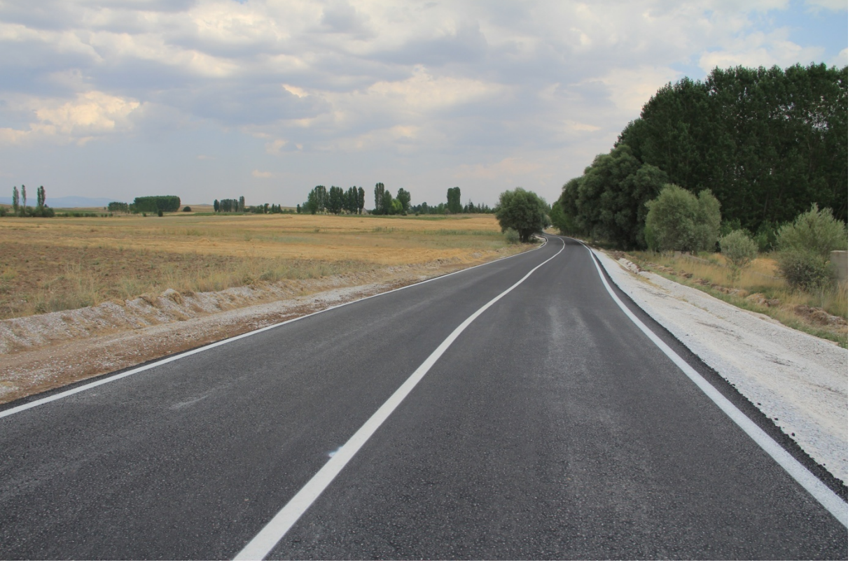
Çavdarhisar-Demiroluk yolu (BSK) Sıcak asfalt çalışması
