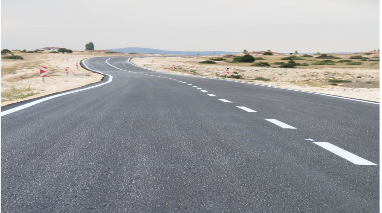
Merkez- Turgutlar yolu (BSK) Sıcak asfalt çalışması
