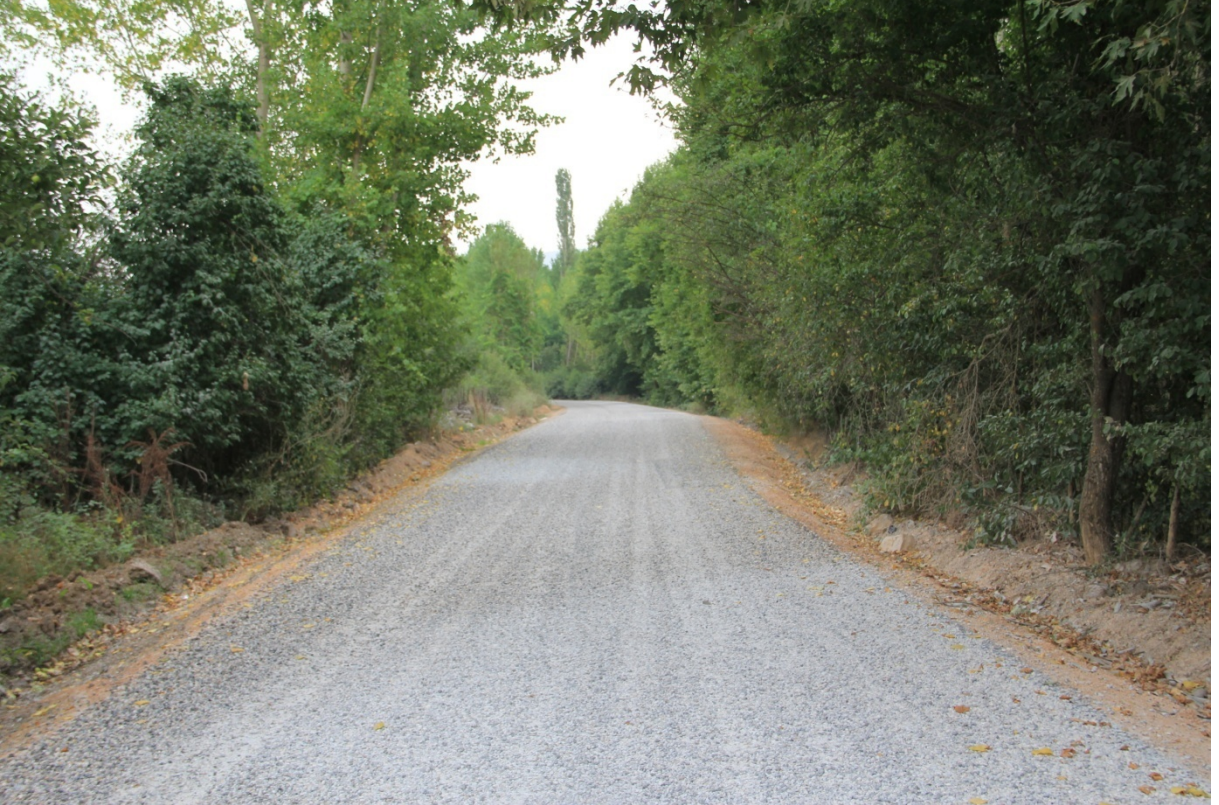
Domaniç-Güney 1,5 km. 1.kat asfalt çalışması
