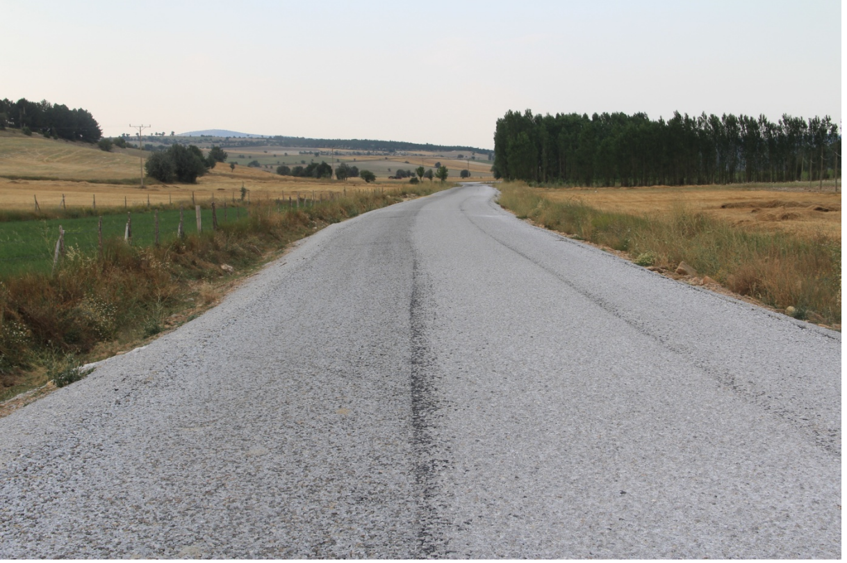
Aslanapa- Tokul-Ören 2 km. 1.kat asfalt yapımı
