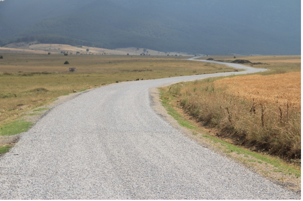
Dumlupınar-Ağaçköy-Alliören yolu 0,5 km. 1.kat asfalt çalışması
