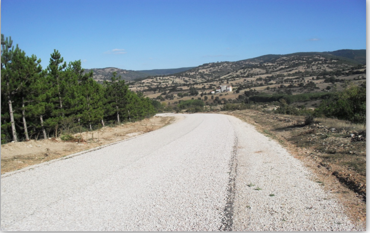
Simav-Koyunoba-Kabaşlar mah.5 km. 1.kat asfalt
