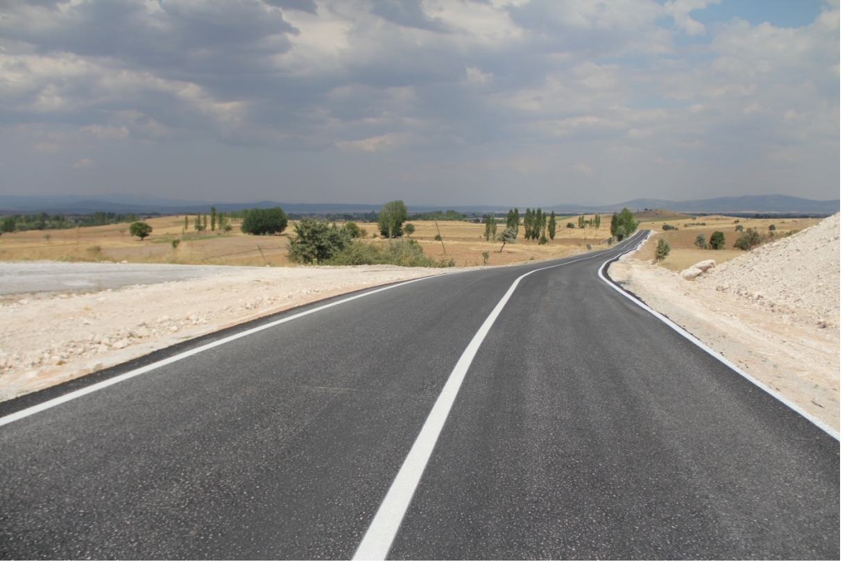
Çavdarhisar-Demiroluk yolu (BSK) Sıcak asfalt çalışması
