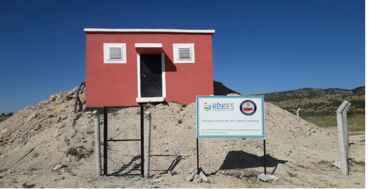
Gediz-Soğuksu köyü 50 m3lük içmesuyu deposu yapım işi
