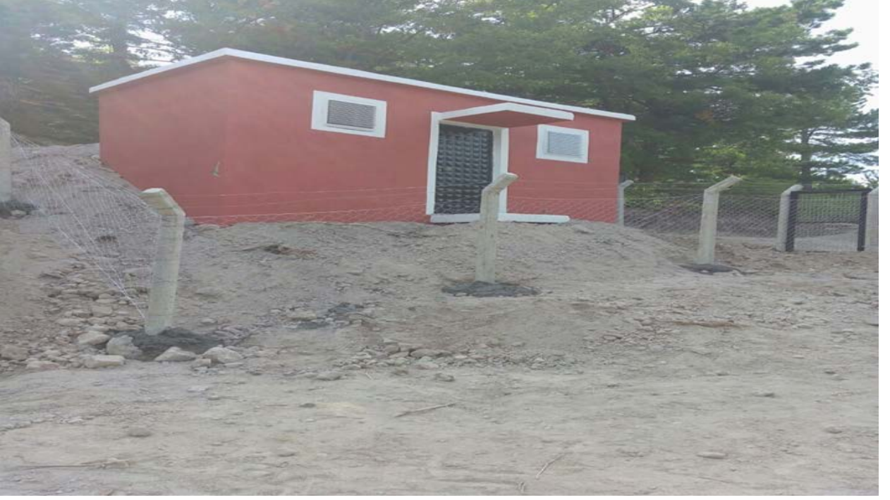
Gediz-Sazak köyü 50 m3lük içmesuyu deposu yapım işi
