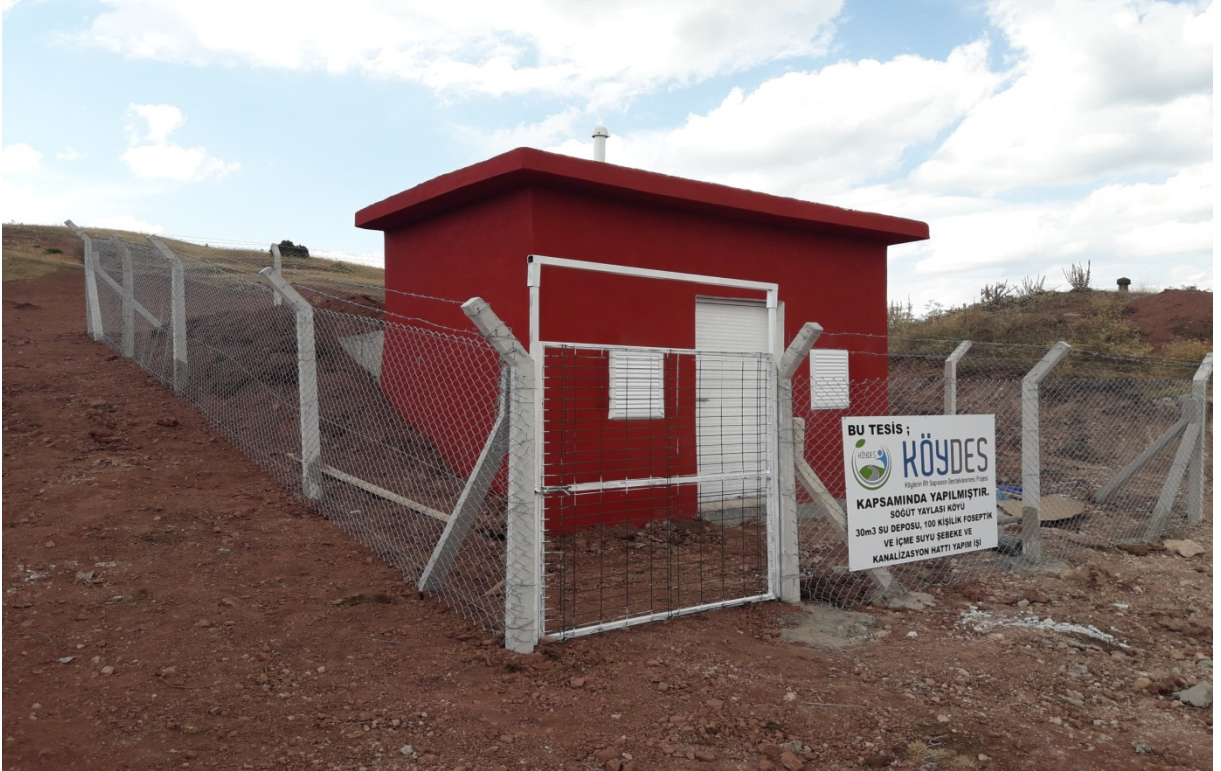
MERKEZ-Söğütyaylası köyü içme suyu 30 m3 Depo Yapımı
