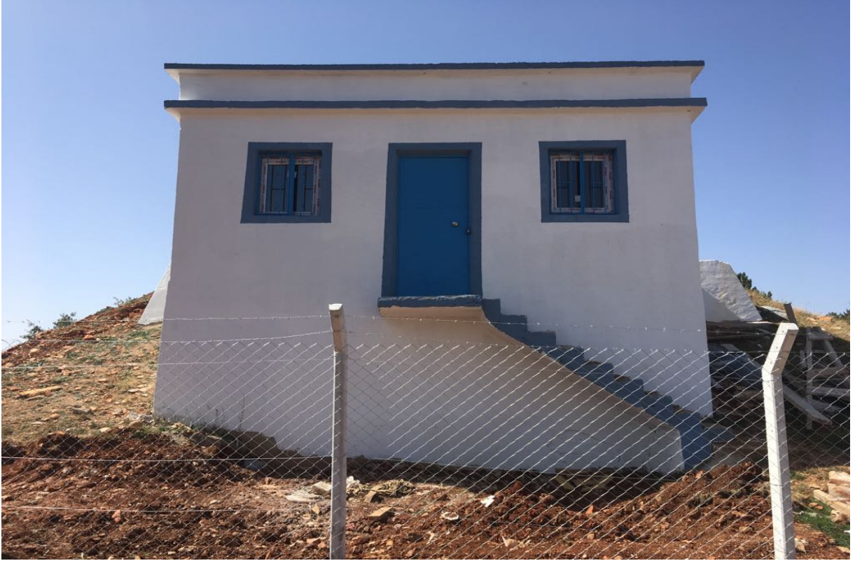
Aslanapa-Çamırdık içmesuyu depo onarımı
