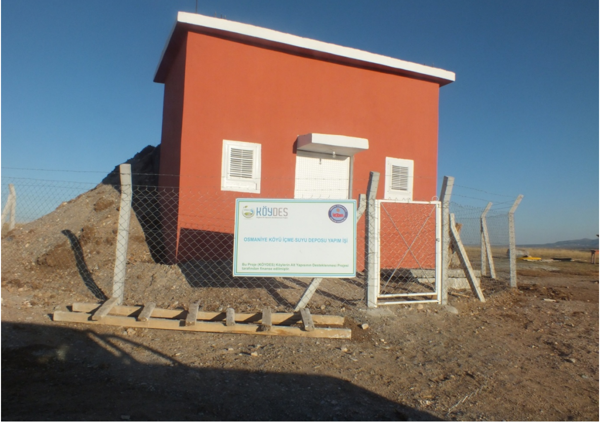
Altıntaş-Osmaniye 50 m3lük içmesuyu depo yapımı
