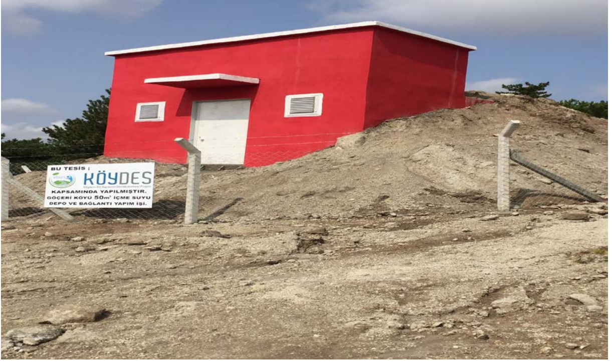
MERKEZ-Göçeri- İçmesuyu 50 m3 Depo Yapımı
