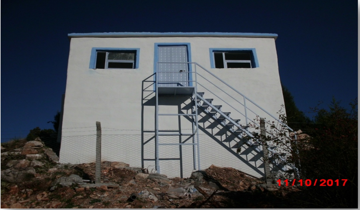
Çavdarhisar –Efeler köyü içmesuyu depo onarımı
