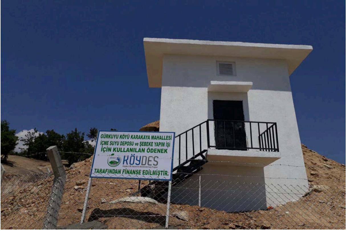
ŞAPHANE-Gürkuyu-Karakaya mah.-içme suyu Şebeke Hattı ve Depo Yapımı 30 m3
