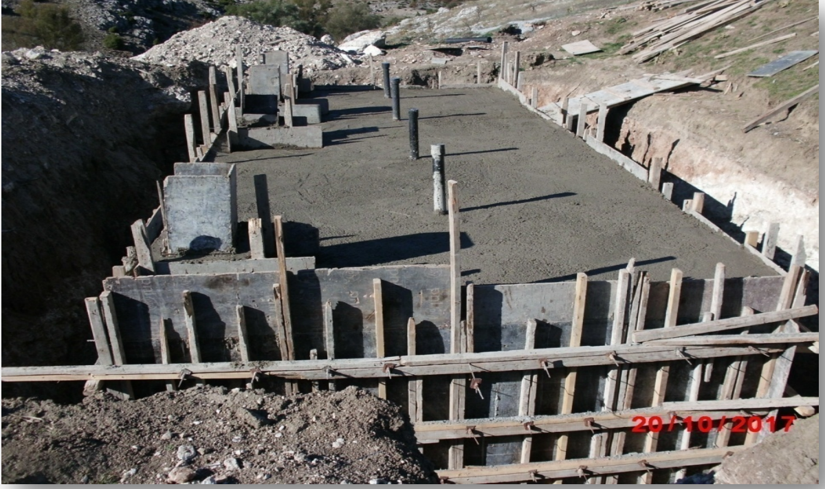
Çavdarhisar-Yenicearmutcuk köyü 500 kişilik foseptik yapımı
