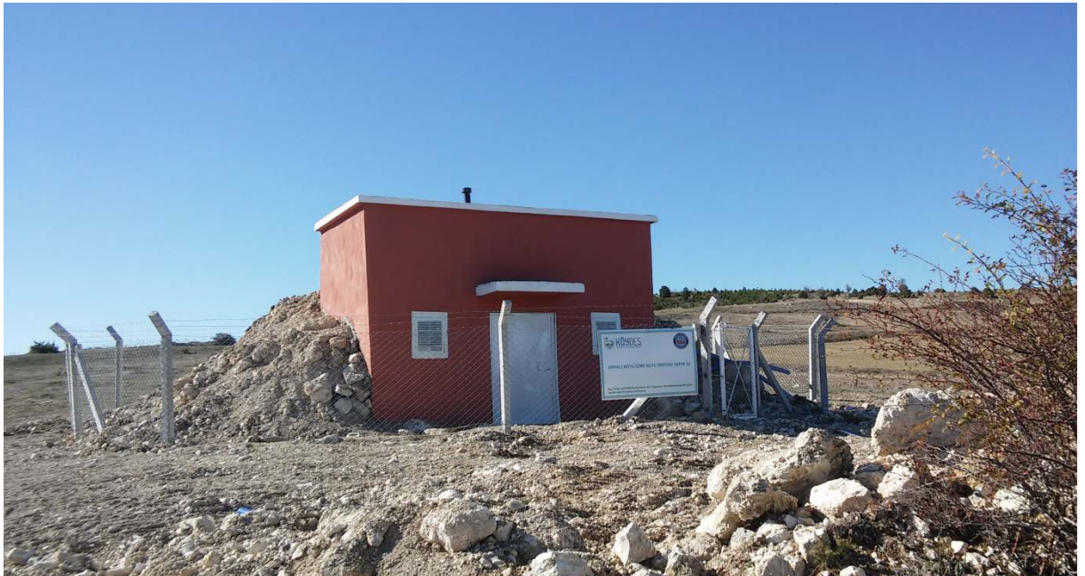
Dumlupınar-Arpalı köy içmesuyu 50 m3lük depo yapımı
