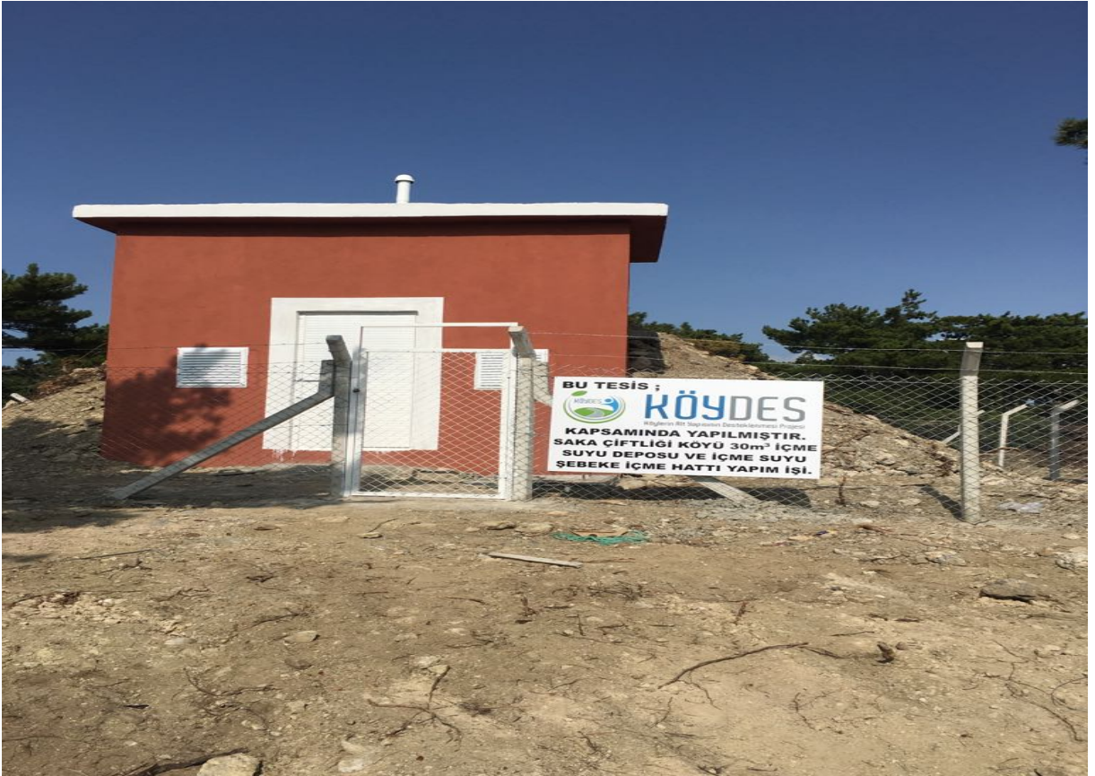
MERKEZ-Saka çiftliği- İçmesuyu 30 m3 Depo Yapımı
