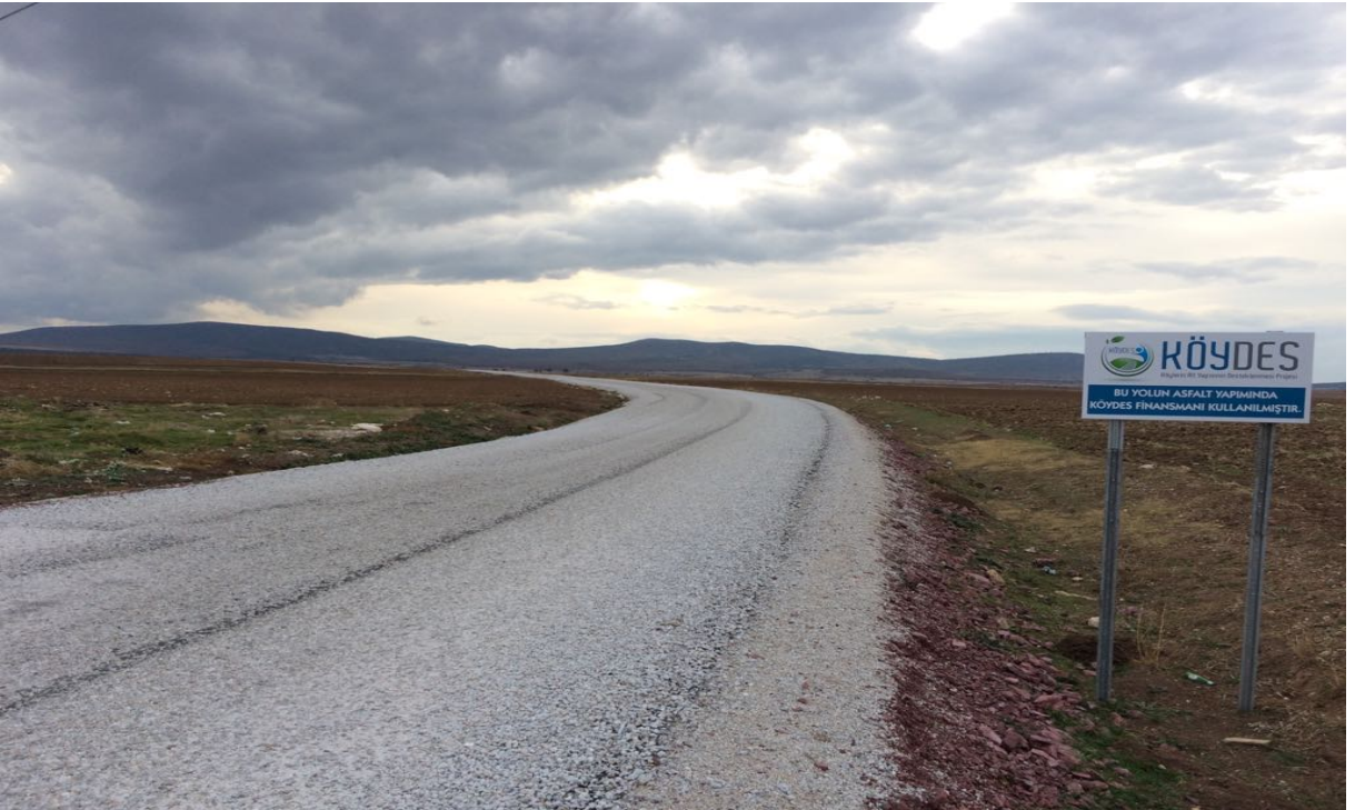
Aslanapa-Terziler –Ballıbaba 1.kat asfalt çalışması
