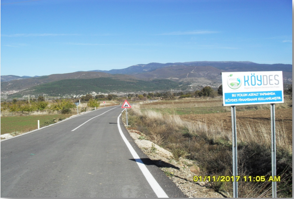
Simav-Yağllar-Kiçir-Kızılıcık –Ballıbaba (BSK) Sıcak Asfalt
