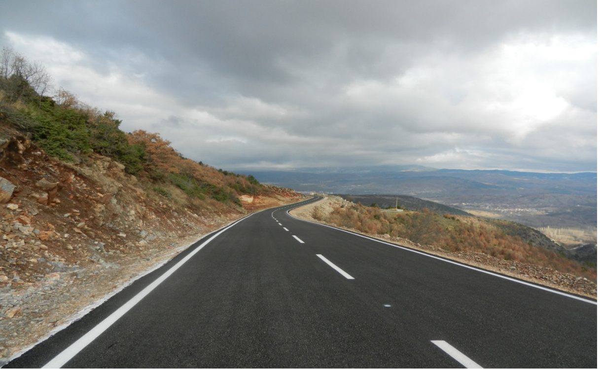
Simav-Samat -BSK(Sıcak Asfalt)
