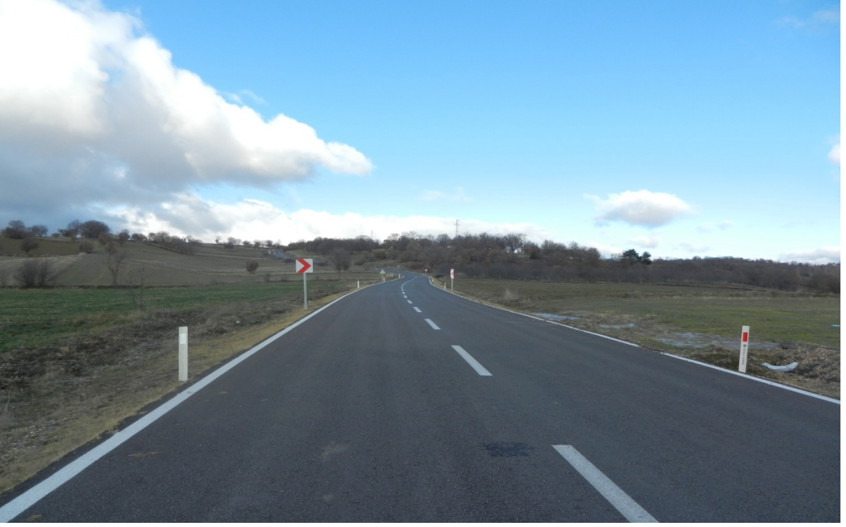
Pazarlar Sofular BSK(Sıcak Asfalt)
