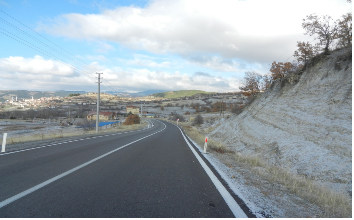
Simav-Kuşu 3km BSK(Sıcak Asfalt)
