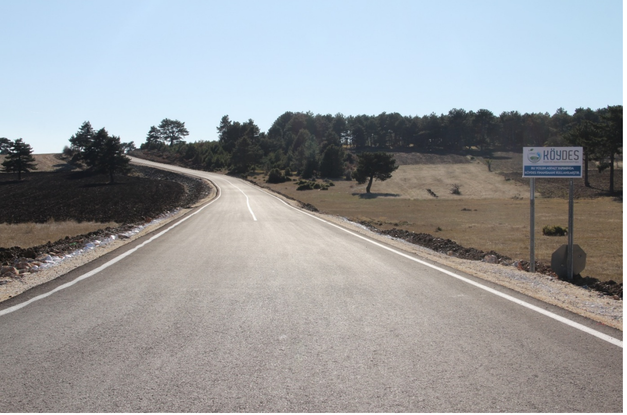
Merkez-Karsak-Suluköy-Kıranşeyh-(BSK) Sıcak Asfalt
