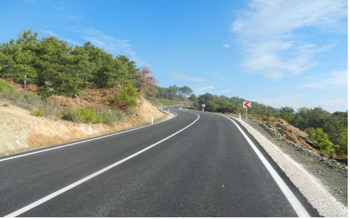
TAVŞANLI-Demirbilek-Bozbelen-(BSK) Sıcak Asfalt
